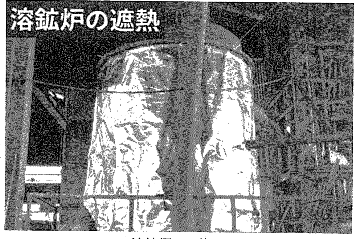
溶鉱炉への施工
